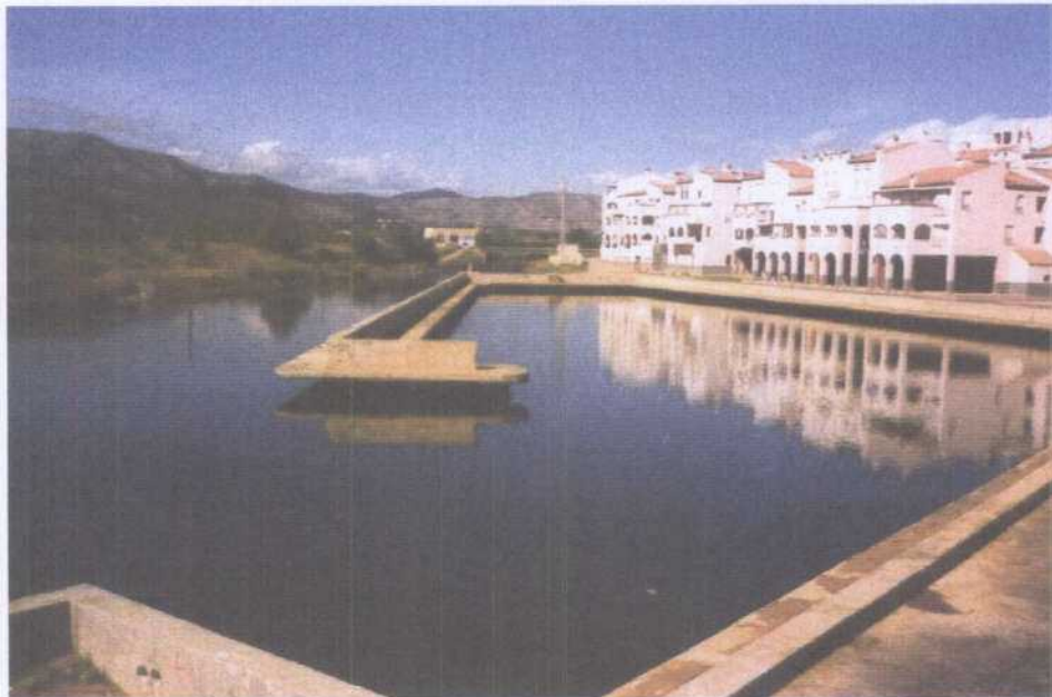
Fotografía 3. Embarcadero de Marina d'Or en el cauce de la rambla de Chinchilla. El agua que ocupa el cauce procede del drenaje del acuífero pliocuaternario de la Plana de Oropesa, como consecuencia de la excavación artificial del lecho por debajo del nivel freático.
